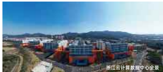
杭钢云计算数据中心
